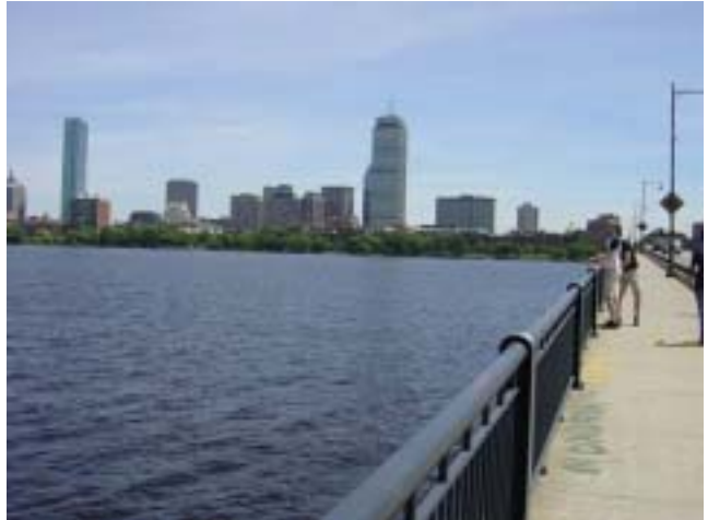
M.I.T.側から臨んだ Boston の街並(右側の橋は Charles River に架かる Harvard Bridge)
